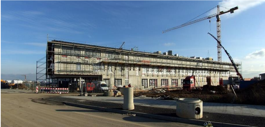
Abb. 6: Gebäude im Rohbau (2011)
